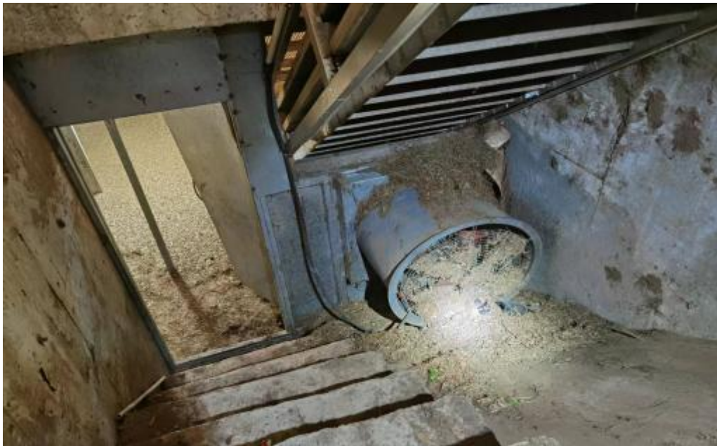
图 7.绿皮仓底部通风机
