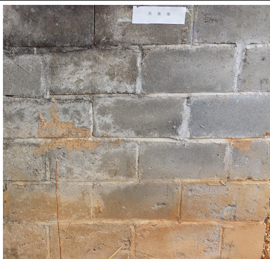
“开采项目”垃圾池
