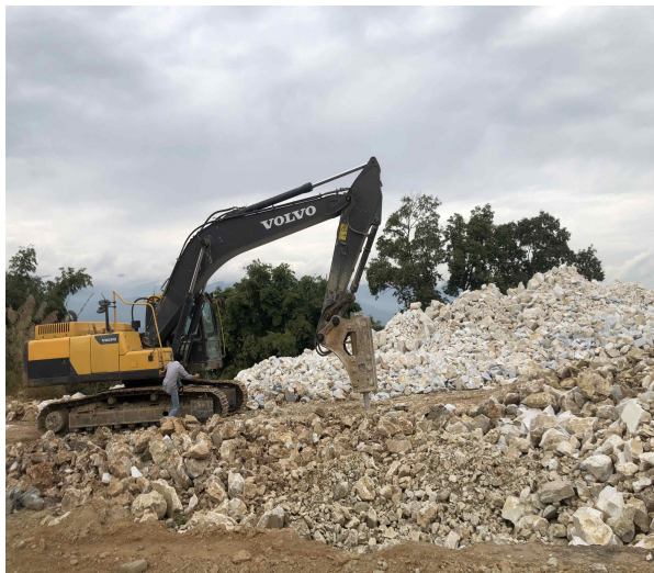
临时原材料堆场
