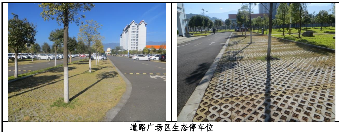
图 4-1 工程措施完成情况图
