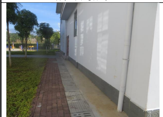
建构筑物区混凝土盖板沟现状
