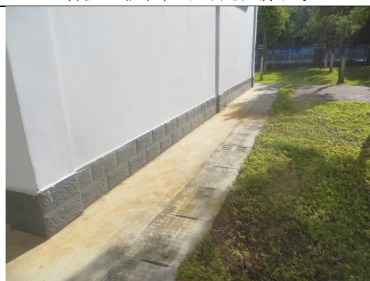
建构筑物区混凝土盖板沟现状
