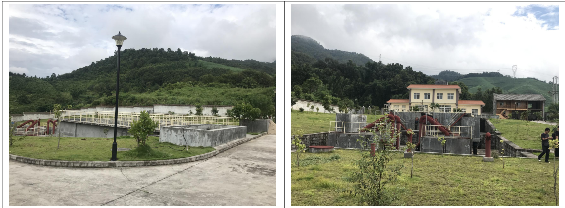
图 2.5-2 旧城镇自来水厂现状
