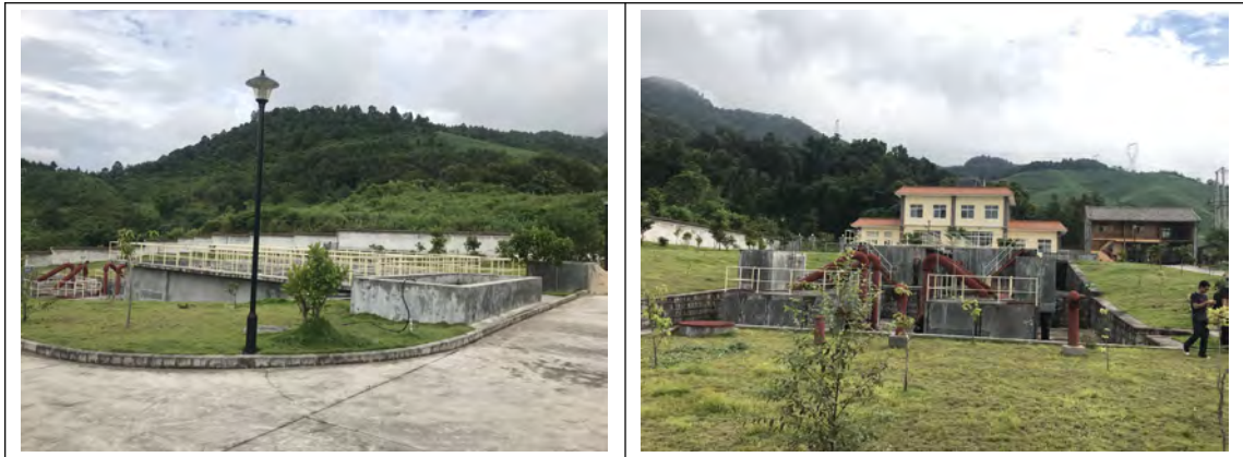
图 2.5-2 旧城镇自来水厂现状
