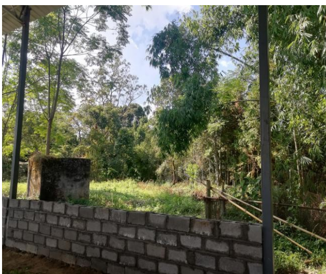
厂区北侧现状
