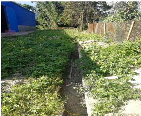
厂区雨水沟渠
