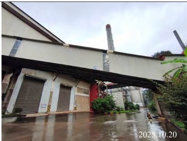
输送廊道封闭
