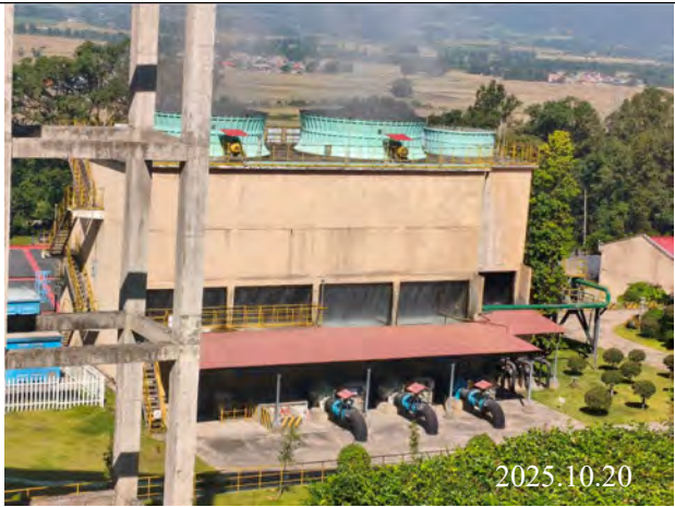
余热发电系统循环冷却水池
