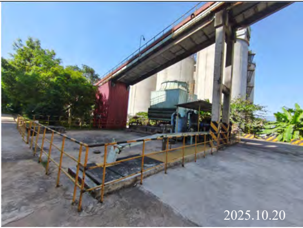
水泥生产系统循环冷却水池
