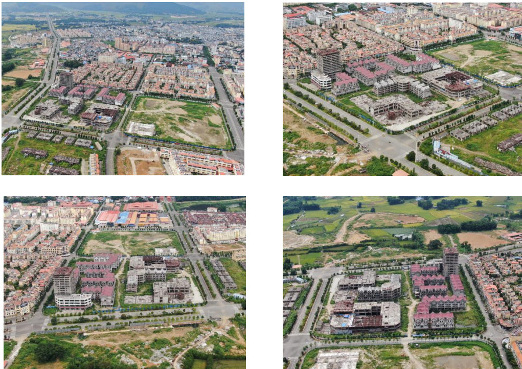
图 2-2 地块现状情况
