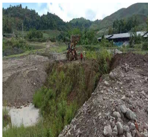
项目区场地现状 2
