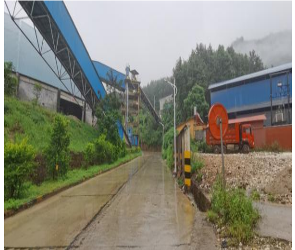
项目区北侧昆钢水泥厂现状
