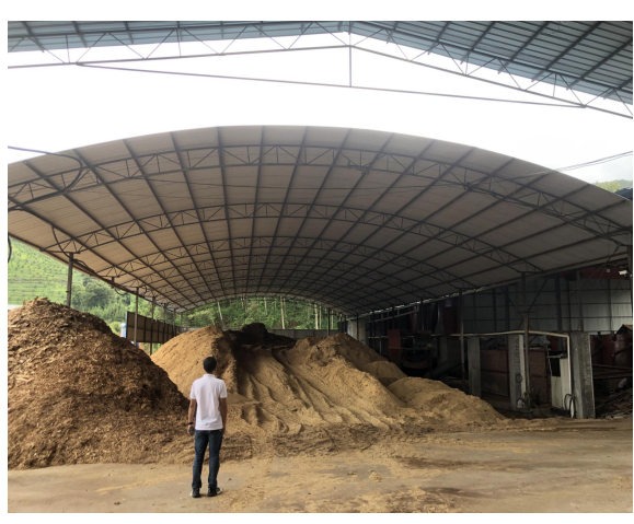
项目区现状及评价人员现场勘查照片
