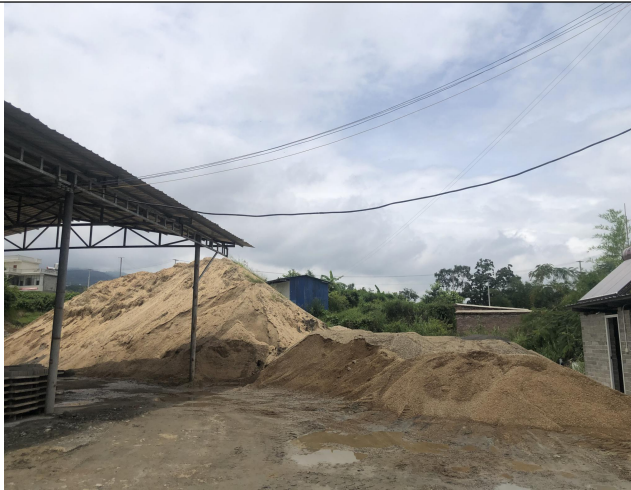
原料堆场现状
