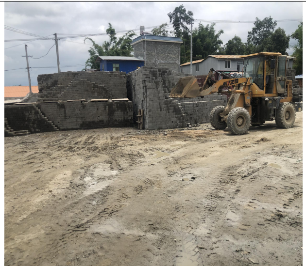
养护、成品区现状
