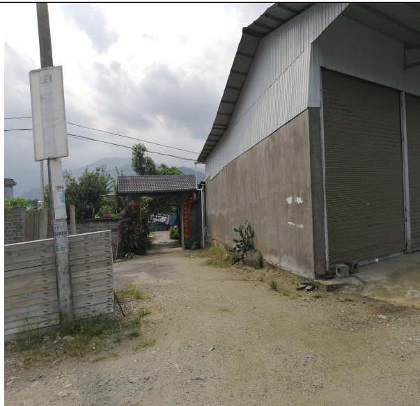
项目北侧及敏感点现状
