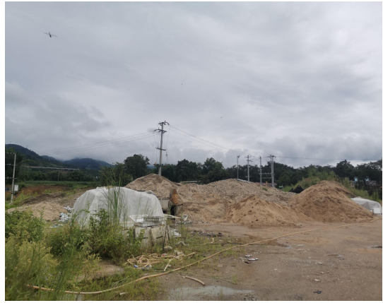
原料堆场现状
