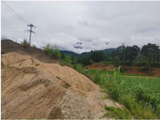
项目区东侧现状
