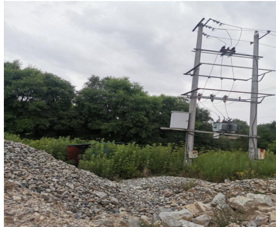
项目南侧现状
