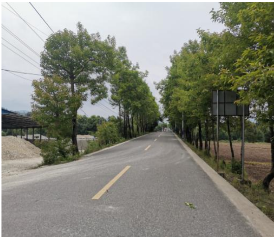
项目西侧现状
