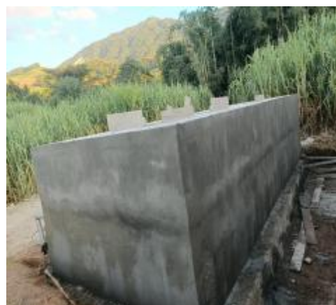
江心坡下组沉淀池
