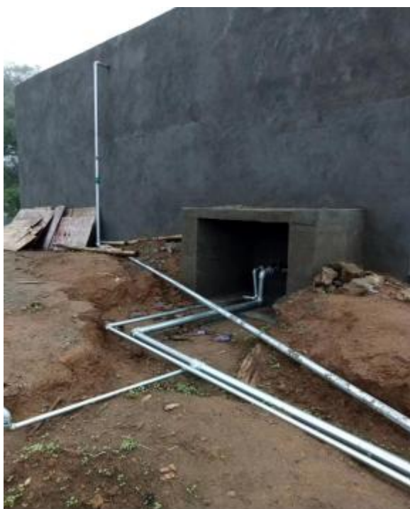
吾帕老寨蓄水池
