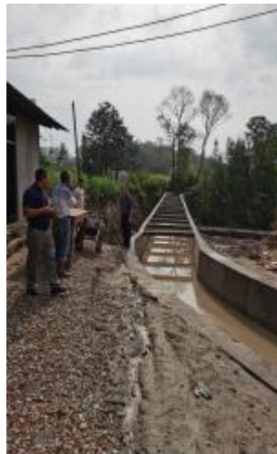
户宋河北沟拉丙村渡槽
