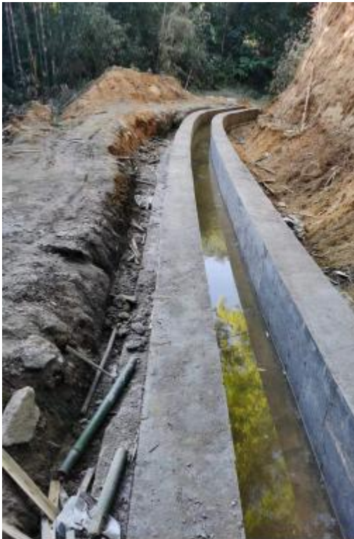
支东大沟线家寨水毁段修复
