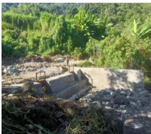
关上村取水坝
